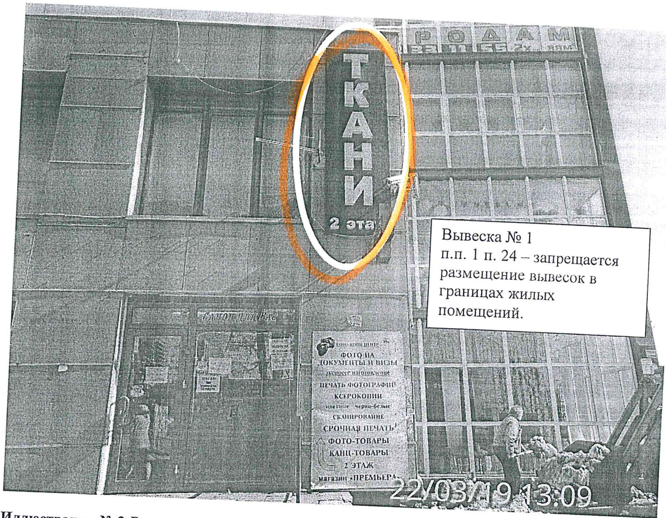
Иллюстрация № 2: Вывеска №1 «Ткани» размещена в границах жилого помещения. Нежилое помещение по адресу: ул. Кирова, д. 23-а, Калининский район, город Челябинск.
